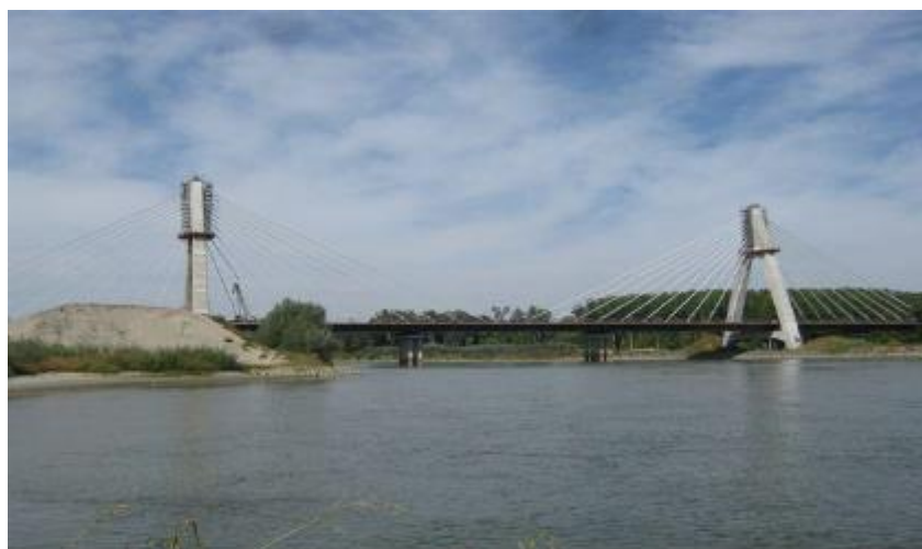
5. ábra: A Dráva híd látványa építés közben
