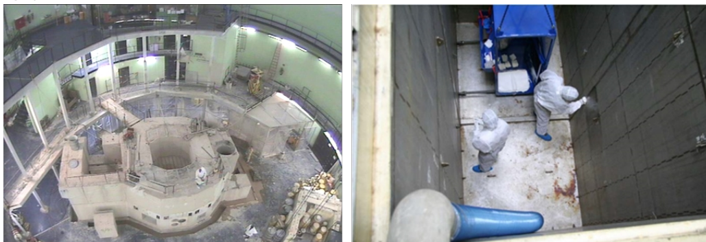
2. ábra: Az ASTRA kutatóreaktor és a fűtőelem-tároló medence bontása
