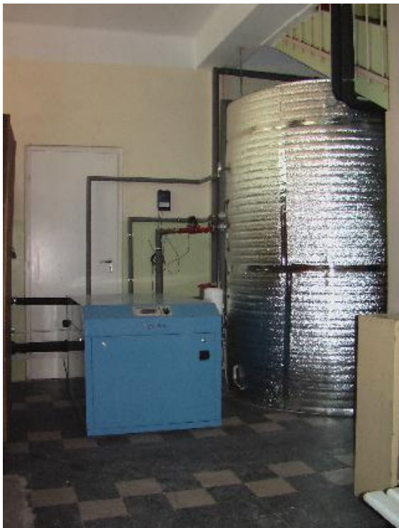
5. ábra. Az Általános Iskola és Napközi Otthon hőszivattyújának és rétegtárolójának elkerítés nélküli fotója
