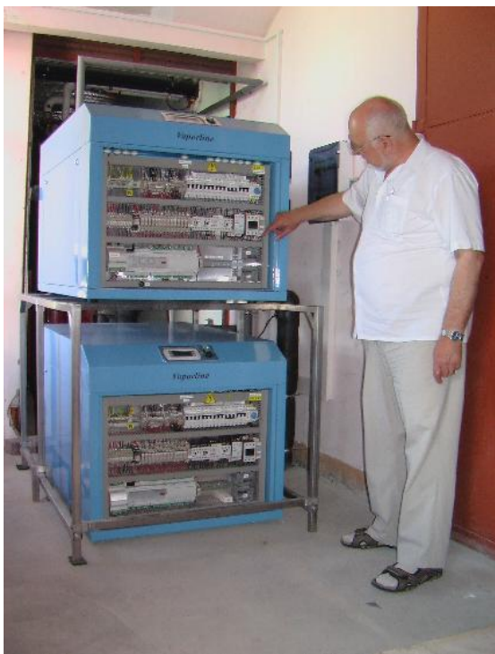
6. ábra. A Művelődési Ház (és a hozzá csatlakozó Sportcsarnok) hőszivattyúinak előlő burkolat nélküli fotója
