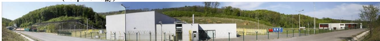
Národné úložisko rádioaktívneho odpadu (Bátaapáti)
